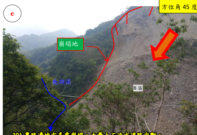
301 農路邊坡有多處崩塌，大量土石造成道路中斷。
