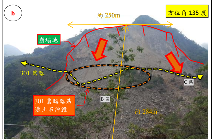
301 農路邊坡崩塌，大量土石沖毀 B 區道路路基，造成道路中斷。
