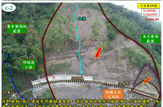
投89線46.3K為舊有崩塌地，本次豪雨之崩塌地位於該崩塌地之右側，由於邊坡植生不佳，常有土石滑落，因此南投縣府已施作明隧道，惟尚未完工，但仍可通行。
