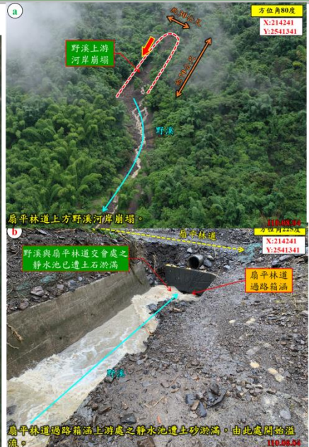
扇平林道過路箱涵上游處之靜水池遭土砂淤滿，由此處開始溢流。 110.08.04
