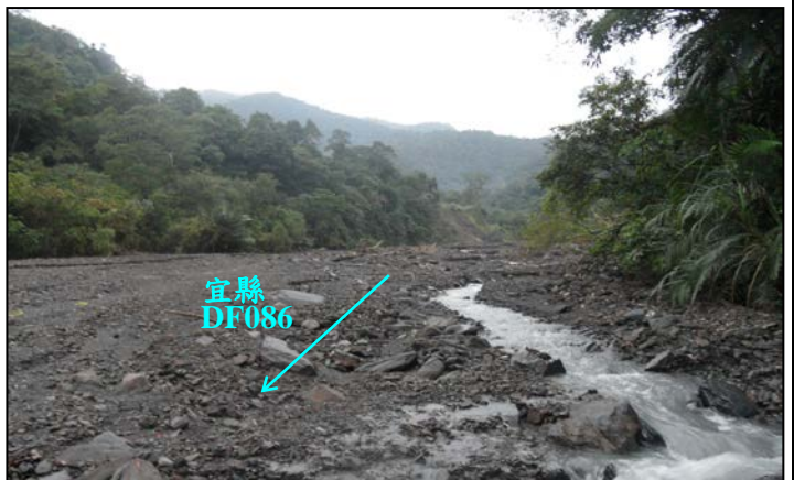
1001 豪雨發生後梳子壩上游土砂堆積 2011.10.26
