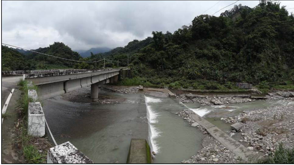
受災位置坡面植生覆蓋良好。
