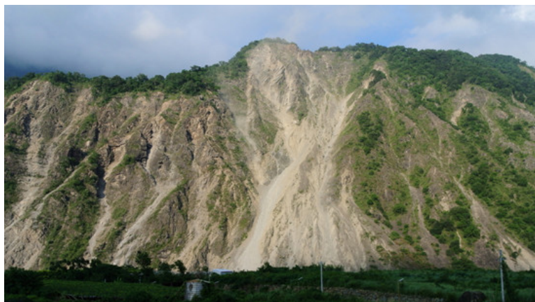
102 年 0602 地震後坡面岩屑崩落岩層出露
