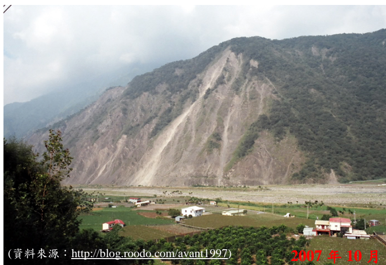
台 21 線新中橫公路筆石段坡面地震前坡面即裸露易崩
