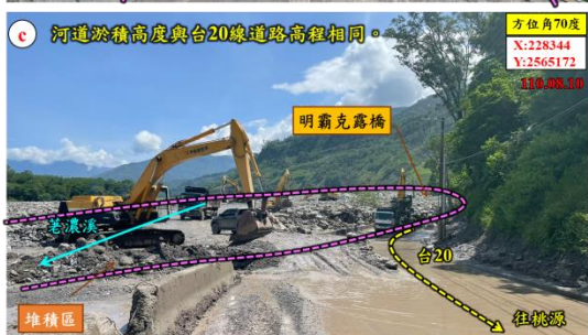
明霸克露橋上游河段有泥沙淤積，且河道明顯變寬。
