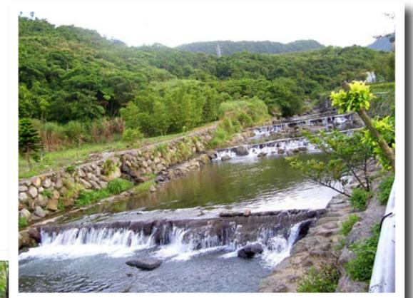
• 採自然生態工法打造的河岸，以砌石護岸和階梯式固床工。
