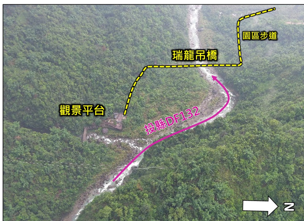
圖 3-5 崩塌區下游經過瑞龍吊橋(拍照日期 115/6/13)
