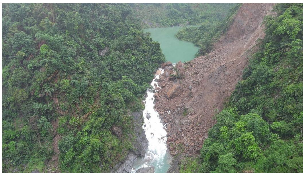
圖 5-1 坡址處土石壩體現況(影像日期 115/6/13)
