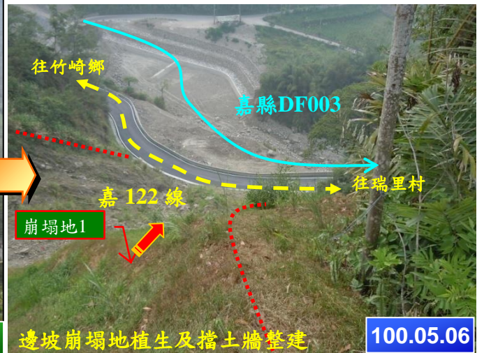
民宅後方崩塌地 植生及擋土牆整建
