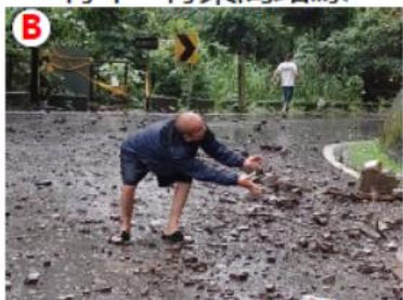
苗栗泰安鄉象鼻村 大安道吊橋路段
