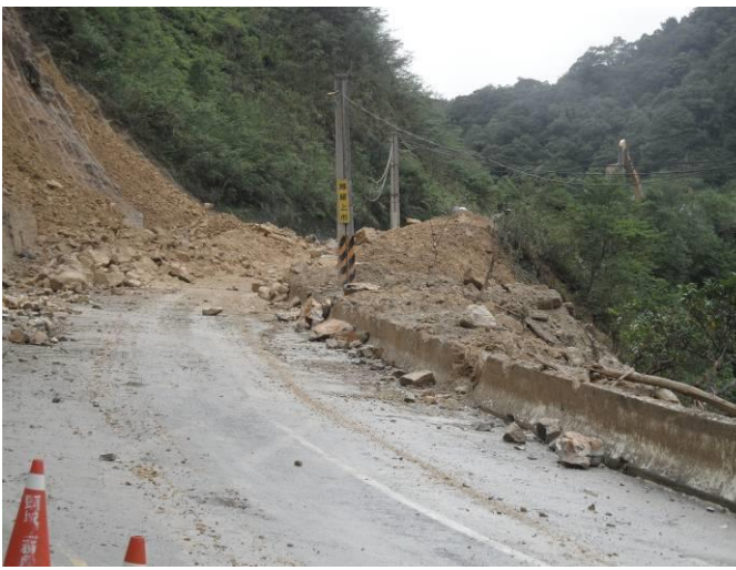
沖蝕： 因逕流沖蝕、地下水滲流或溪水淘刷，導致基礎土壤流失、表面沉陷 【98 年莫拉克颱風南投縣信義鄉神木村崩塌災害】
