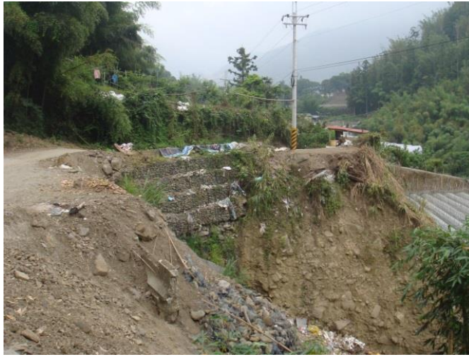
沖蝕： 因逕流沖蝕、地下水滲流或溪水淘刷，導致基礎土壤流失、表面沉陷 【98 年莫拉克颱風南投縣信義鄉神木村崩塌災害】
