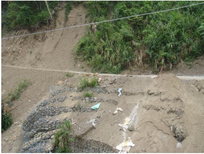
沖蝕： 因逕流沖蝕、地下水滲流或溪水淘刷，導致基礎土壤流失、表面沉陷 【98 年莫拉克颱風南投縣信義鄉神木村崩塌災害】
