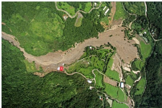
有明顯土石堆積區(形成沖積扇或河道淤積) 【100 年南瑪都颱風屏東縣滿州鄉老佛山】
