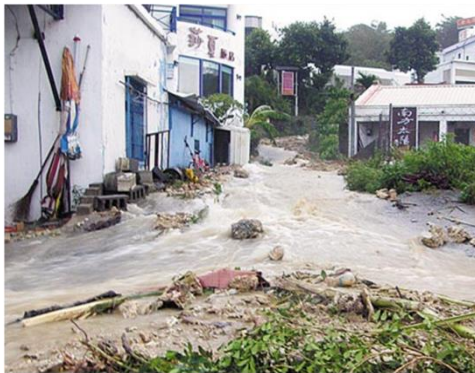
溢淹： 河道排洪斷面不足，溢淹至路面及保全民宅 【100 年南瑪都颱風屏東縣恆春鎮潭子路洪水災害】
