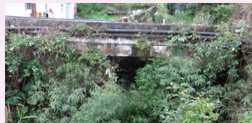
在現場踏勘階段，協力團隊帶領村長至溢流點（橋樑）進行環境的巡視及涵洞的現況調查，由照片可見渠道內植生茂密，有可能導致土石流發生時通洪斷面不足而導致溢流。
