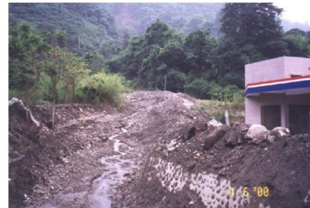
照片 2.58 編號仁愛 002 土石流危險溪流，未興築混凝土護牆（攝影日期 89年 4月 6日）（林美聆攝）
