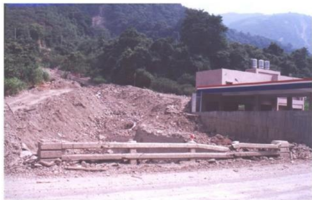
照片 2.59 編號仁愛 002 土石流危險溪流，已興築混凝土護牆（攝影日期 89年 7月 1日）（王國隆攝）
